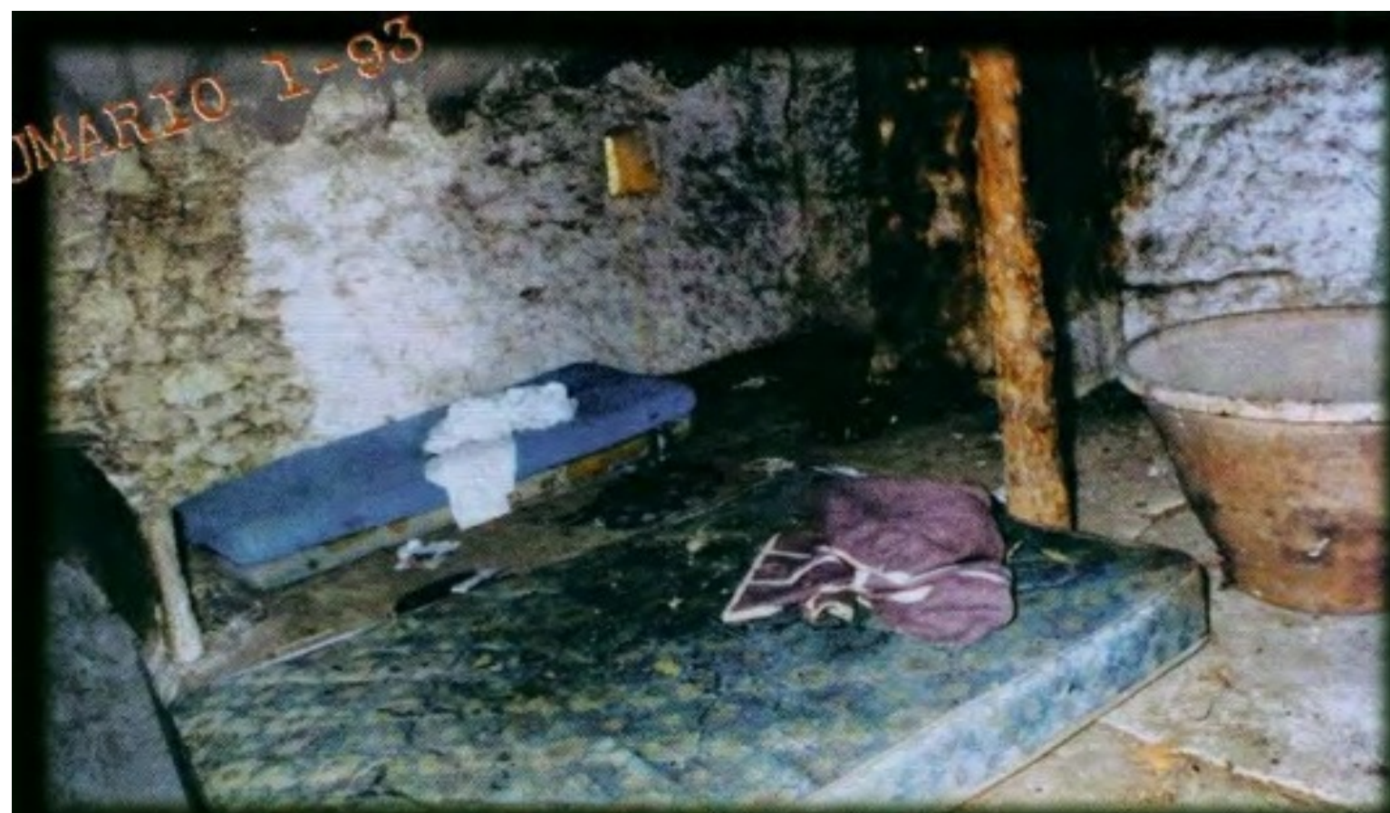
FOTOGRAFIA NUM. -39 Vista general de la buhardilla.
