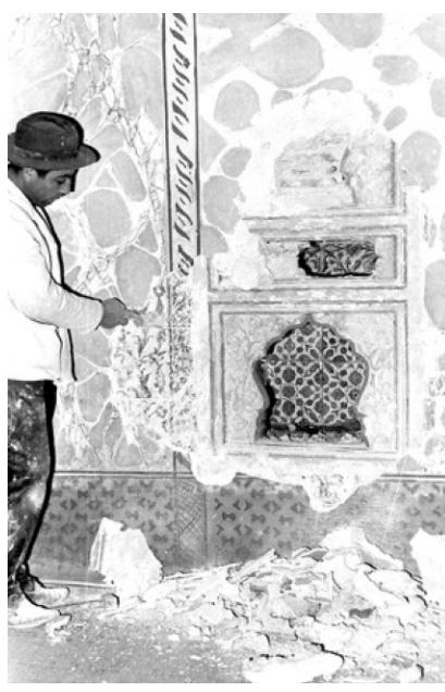
Valide Sultan Yemek Odası'nda yapılan restorasyonda çiniler üzerindeki sıvaların kaldırılışı
