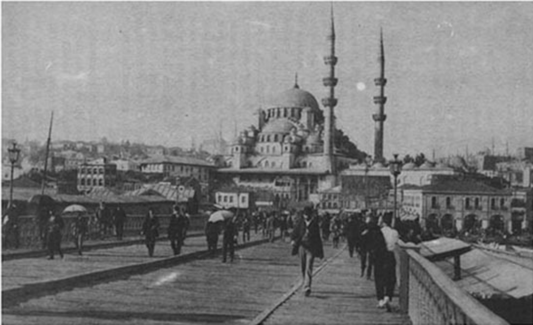
1878'de montajı tamamlanan üçüncü Galata Köprüsü. Gövdesi demir, döşemesi ahşap bu köprüden yürüyerek geçen acemilerin başına neler geldiğini, tahtalar arasına topukların takılıp kırılışını Ahmet Rasim anlatır...
