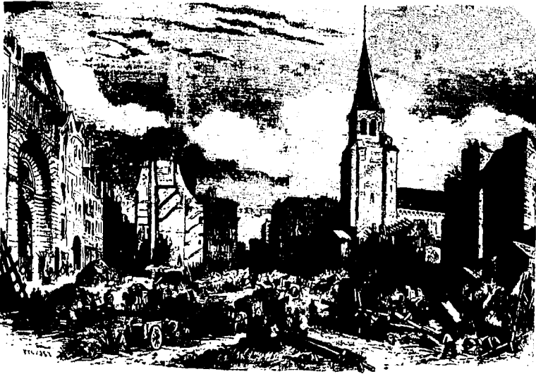
Resim 1.3 İkinci İmparatorluk Paris'inin Haussmann tarafından yaratıcı biçimde yıkılışı: Saint-Germain meydanının yeniden inşası.
