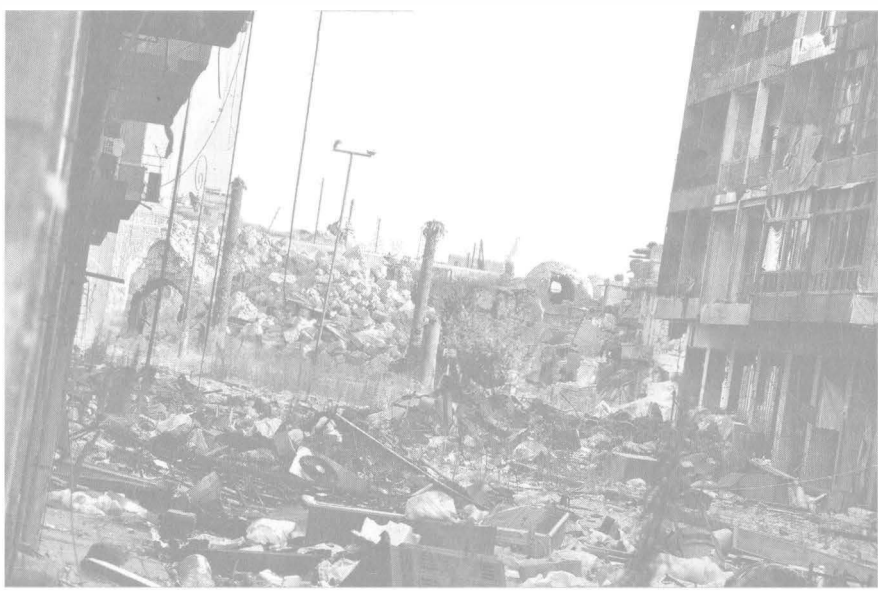
Halep'te tarihi Emeviye Camii'ne giden yoldan bir görüntü. Cami de zarar gördü.
