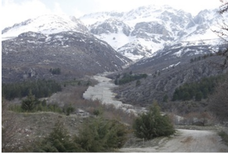
Kapı Dağı'na yapılan set
