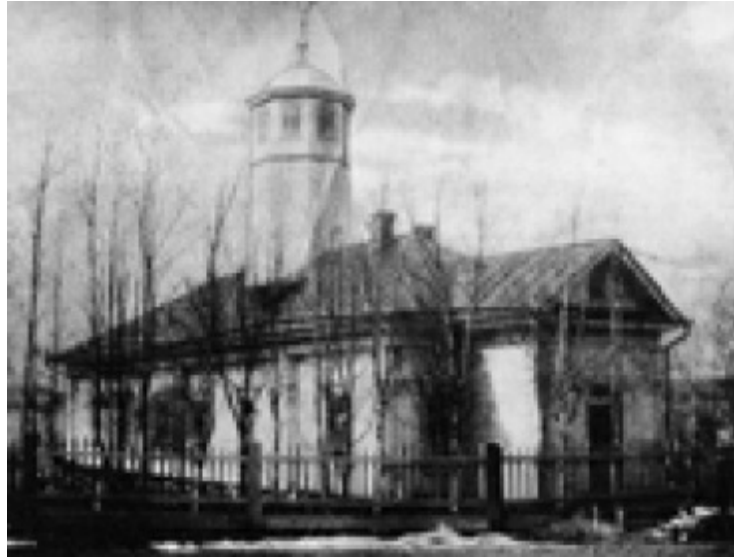
Kosturma Camii. Bediüzzaman 1916-1918 yılları arasında Kosturma’da sürgünde iken Tatarların kefaletiyle Volga nehri kenarında kaldığı cami. 1780 yılında Tatar Müslümanlar tarafından yaptırılan cami, 1930 yılında komünist yönetim tarafından
