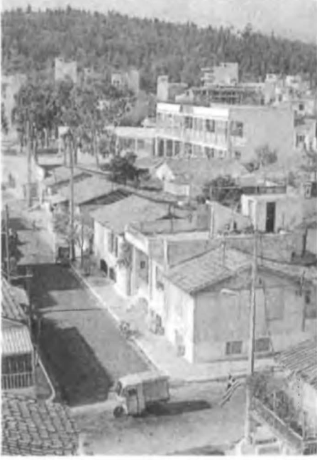
Resim 3. Yerevan'ın bir ucundaki ilkokul iki yerleşim bölgesine birden hizmet verir. Zeminden yüksek kaideler üzerine kurulmuş prefabrike evler bodrum katı odalarının eklenmesine olanak veriyordu.
