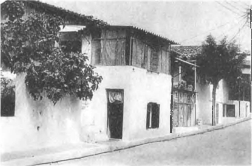
Resim 6. Ek yaşam alanı yaratma gereksinimi, kaldırımın üzerine veya altına çeşitli tipte çıkıntılar inşa edilmesine neden olmuş.
