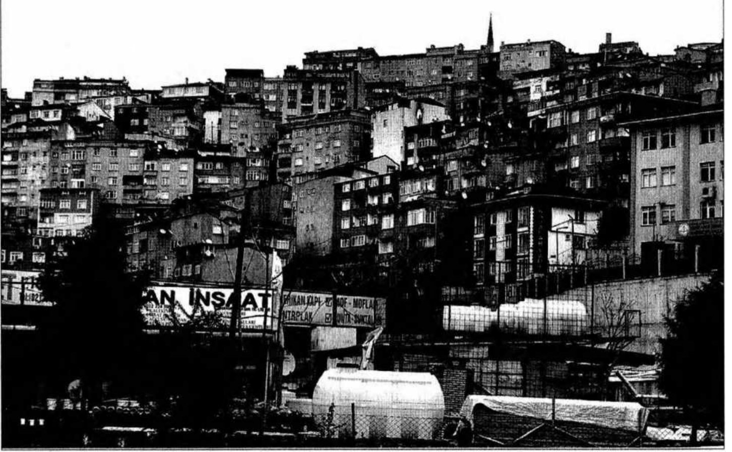
Sanayi Mahallesi'nde, dip dibe geçmiş apartmanlar.
